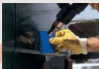
6. De lijmresten verwarmen en met de speciaal spatel verwijderen.
