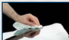
8. Eventueel achtergebleven lijmresten met speciaal spatel en glasreiniger verwijderen.
