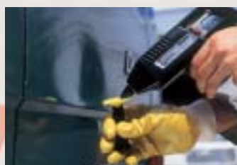
2. Juiste adapter op de handgreep plaatsen en de speciaallijm in het midden opbrengen.
