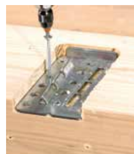
Monteer (schroef) de verbinder in de hoofddrager in het uitgefreesde gedeelte.
