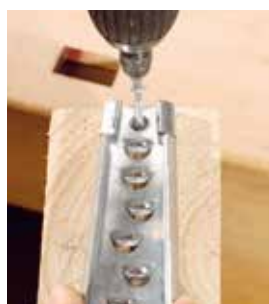
Het conisch gevormde deel op het afgetekende hart van de nevendrager centreren en vastschroeven. Zorg dat de verbinder goed op de balk draagt.
