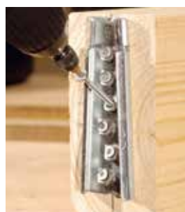
Zorg ervoor dat de schroeven in een hoek van 35° worden ingeschroefd.
