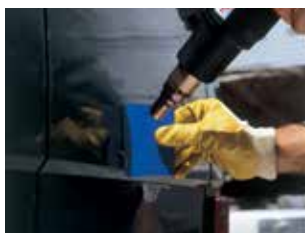
6. De lijmresten verwarmen en met de speciaal spatel verwijderen.
