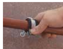
Verbindingsschroef dichtdrukken, fixatie.
