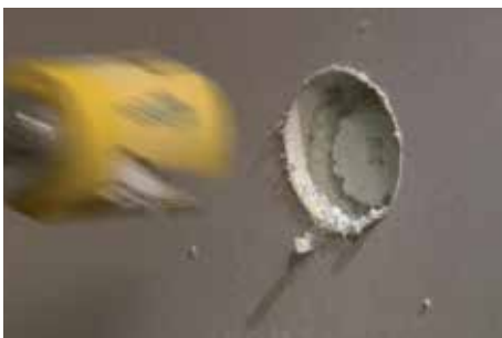
Gips en gasbeton
