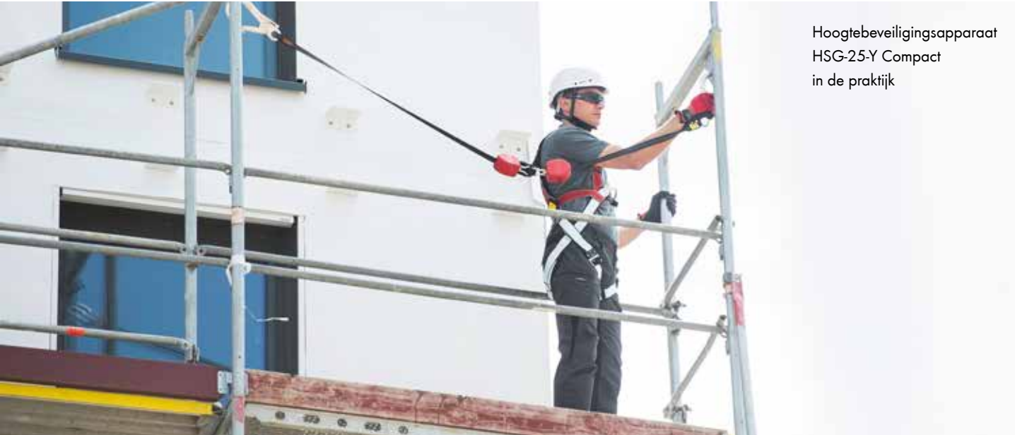
Hoogtebeveiligingsapparaat HSG-25 Compact in de praktijk
