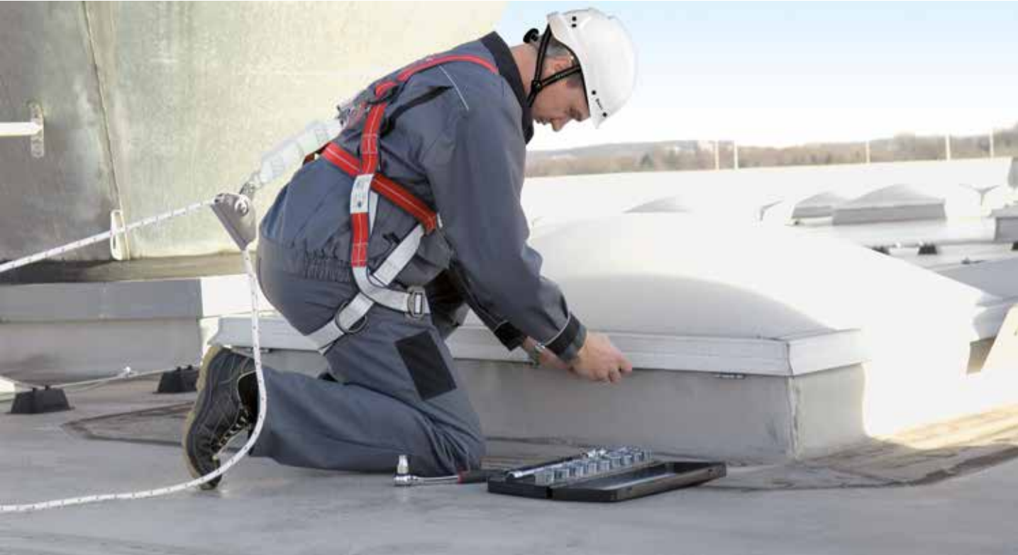
Praktijkvoorbeeld meelopende valbeveiliging
