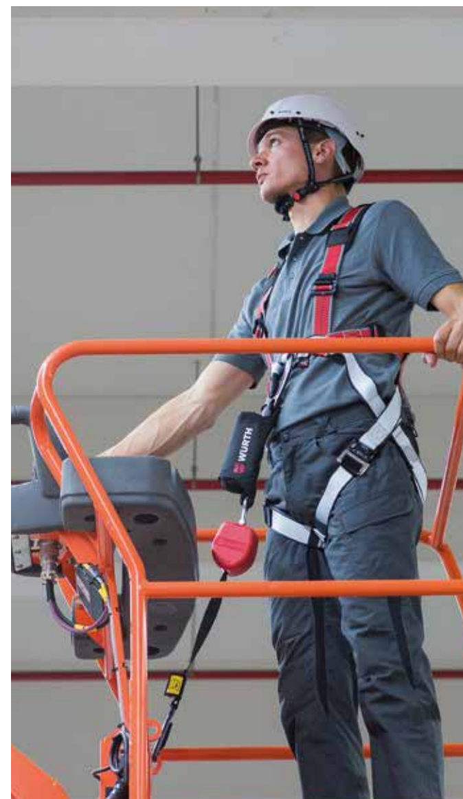
Valbeveiligingsset in gebruik bij hoogwerker
