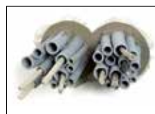
Vul de overgebleven openingen op met mortel, beton of gips.
